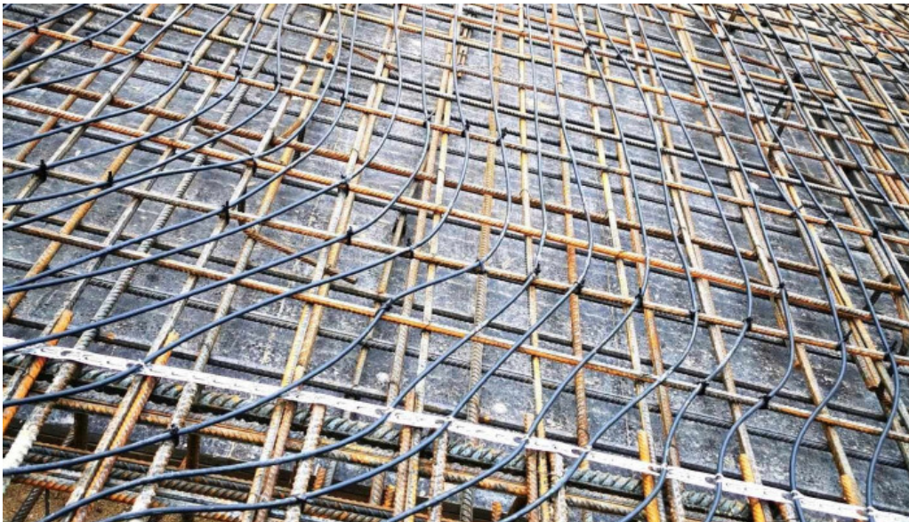
Kraftbau stahl kft epulet
