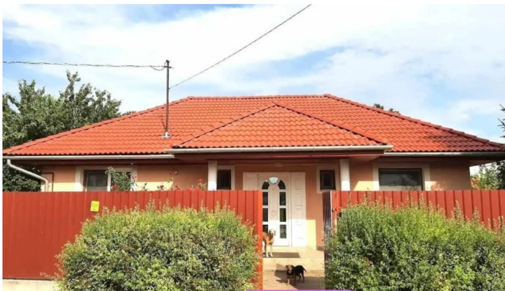
Tetőépítés barna barna hajdunánás
