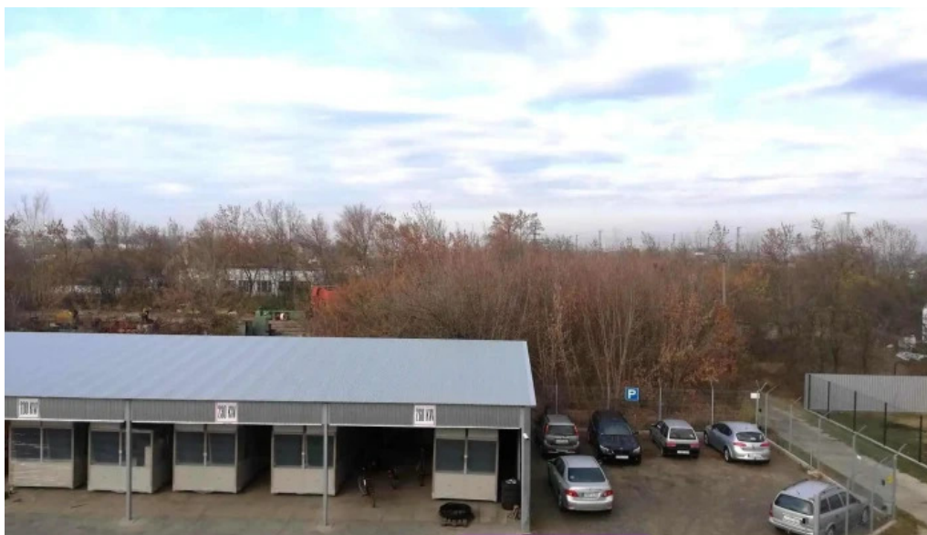
Fém és műanyagfeldolgozó Kft. fmf by Johnson Controls összes
