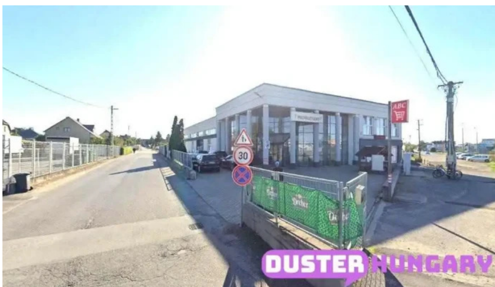
Szabolcs komplex 2000 kft nyiregyhaza
