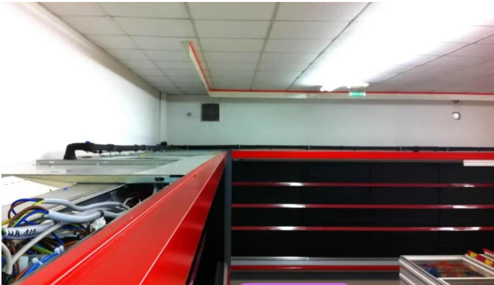
Korrekt kft hűtőtechnika belül
