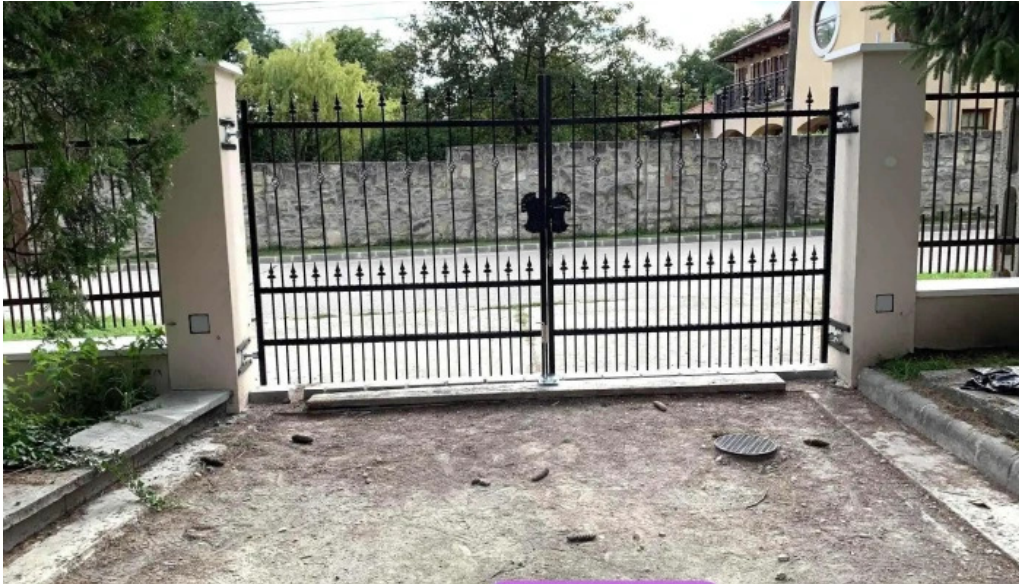
Orbantecheu kaputechnikalakatos munka kivitelezes osszes
