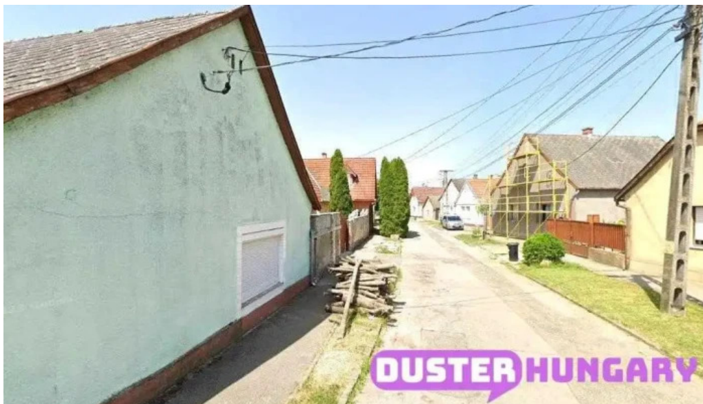
Bogi montage bau art kft siklos
