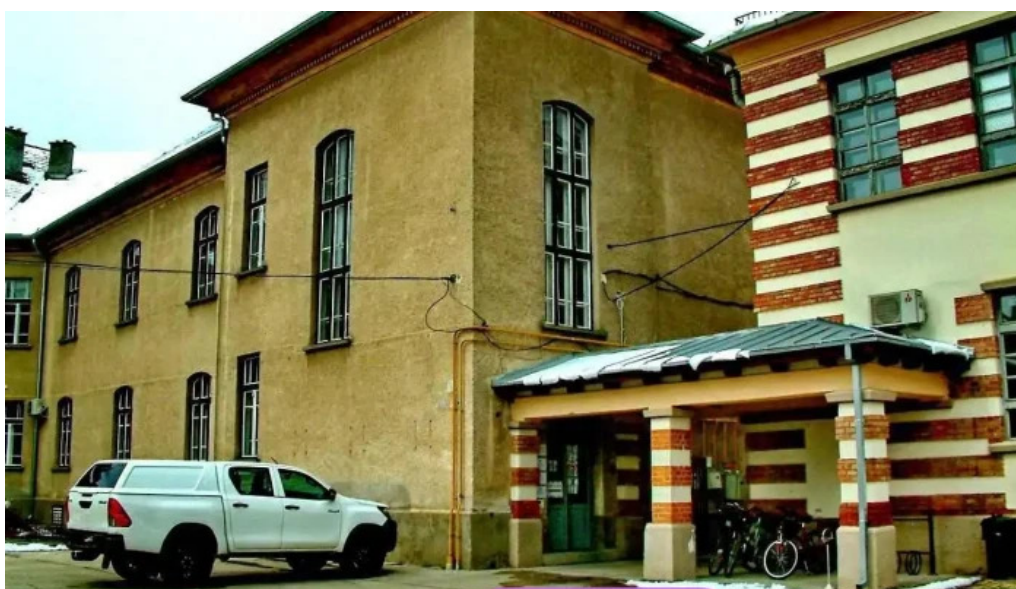
Kormanyablak baja hazavaro pont baja
