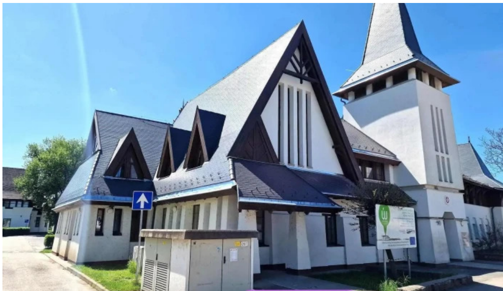
Csengeri járóbeteg szakellátó központ legfrissebb
