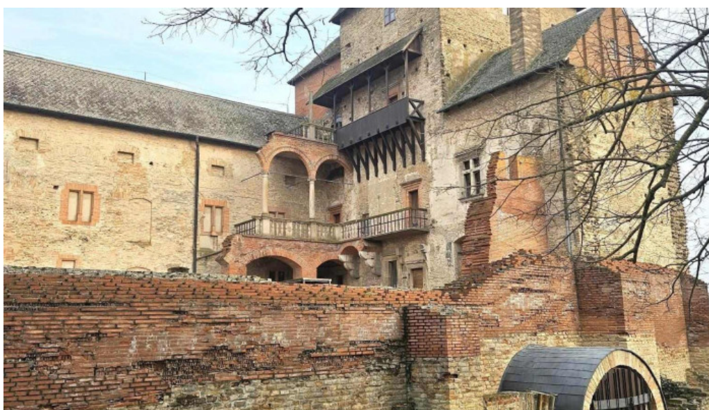
Simontornyai var boltiv
