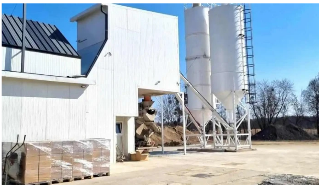
Ketece kft baktaloranthaza betonkevero telep kulso
