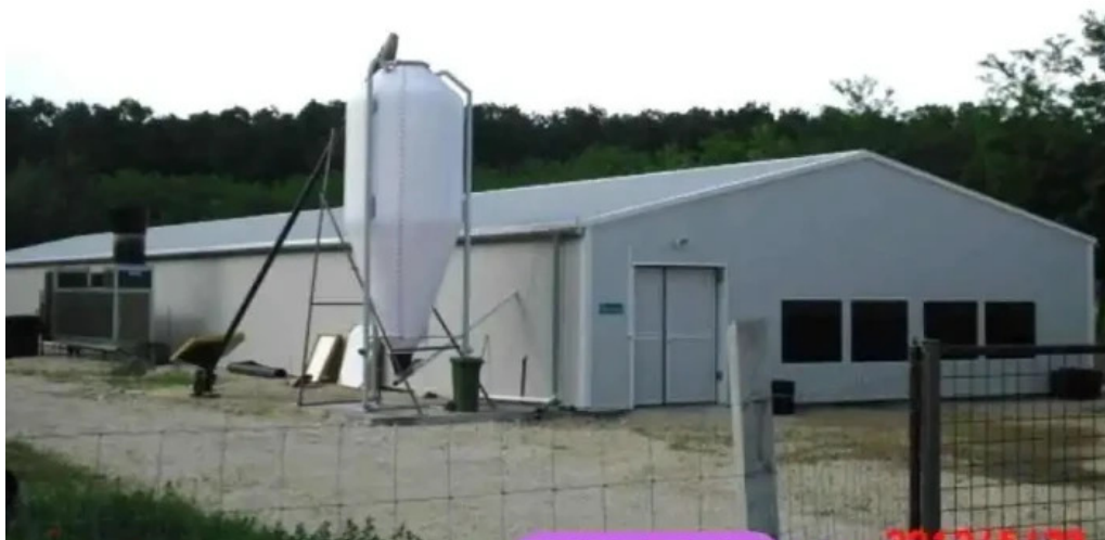
Acélszerkezet technika kft osszes
