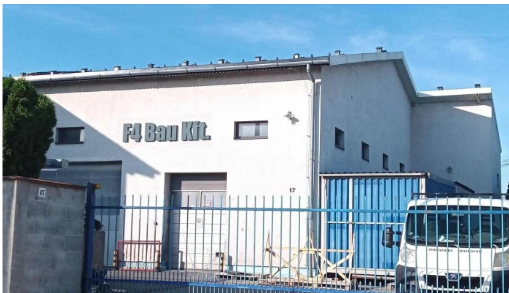
F4 bau kft kerites
