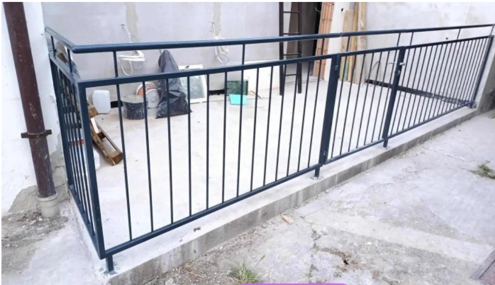
Acel muvek lakatos munkak hegesztes kapujavitas acél szerkezetek osszes
