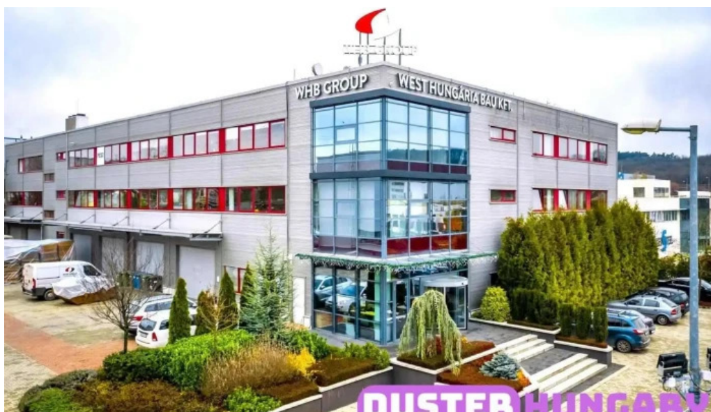
West hungaria bau kft osszes
