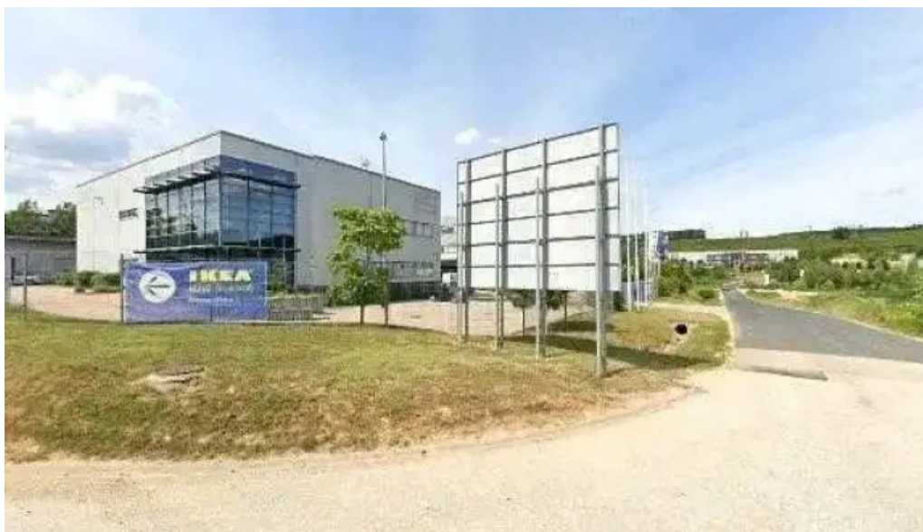
West hungaria bau kft utcakep es 360deg
