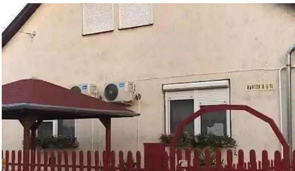
Alkusz lak haz abadszalok
